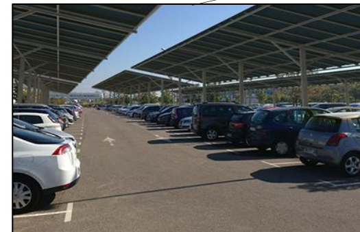
Installation de panneaux photovoltaïques au dessus des aires de stationnement
